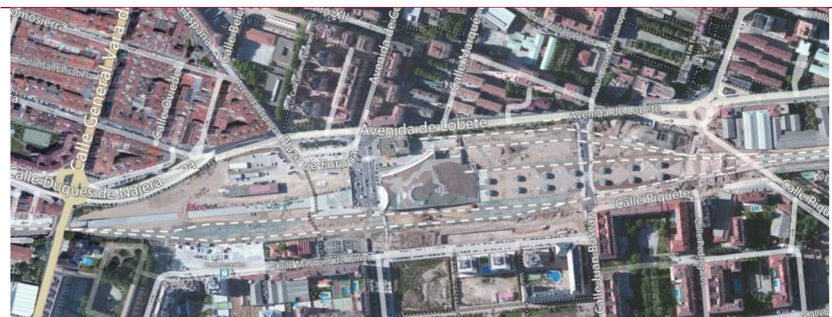
Ilustración 26. Foto aérea de la nueva estación de ferrocarril de Logroño
